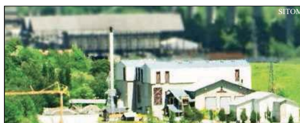
Photo 5 : usine d'incinération de Passy
