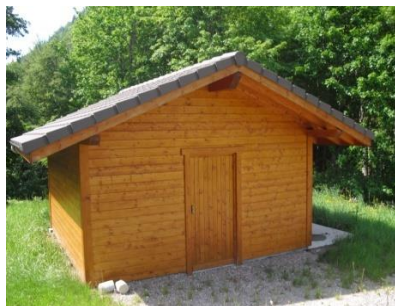
Poste de refoulement des Mouilles.
